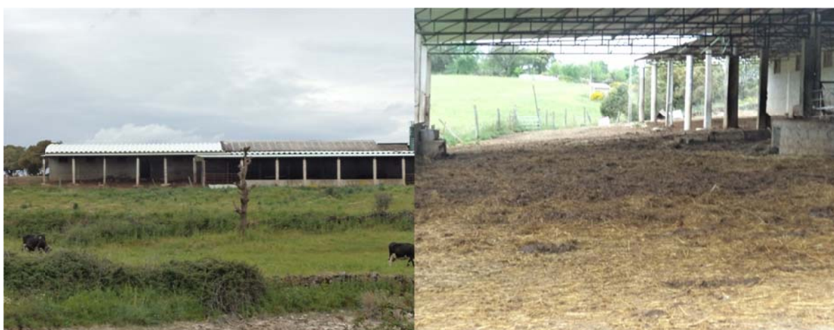
Figura 2.2. Vista geral do estábulo e pormenor de cobertura (exploração B)
