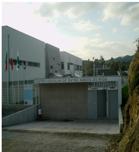
Fig. 1 - Centro Escolar de Entre-Ambos-os-Rios
