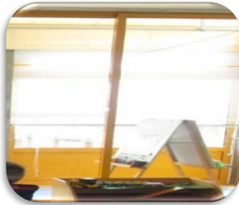
Figura 17- Área da pintura
