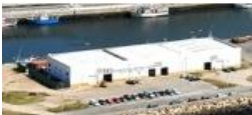
Figura 1: Instalações da MCR, em Viana do Castelo
