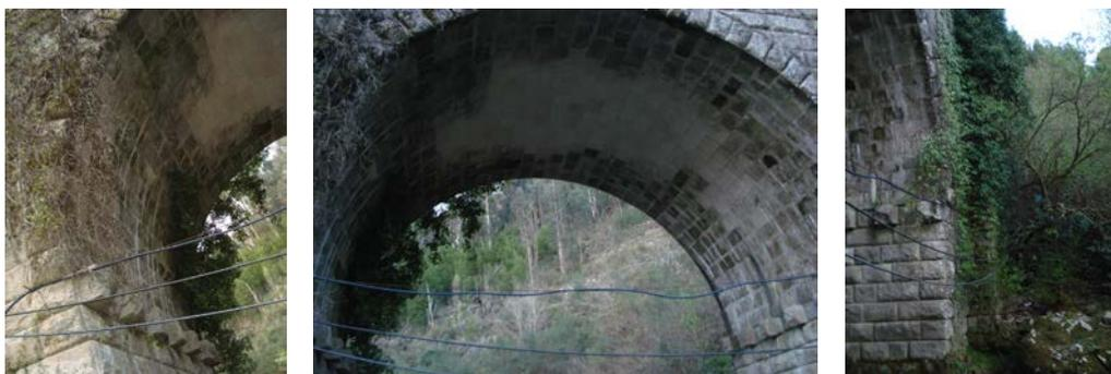
Figura 6.10 - Ponte de Cabreiros: tubagens apoiadas na ponte.
