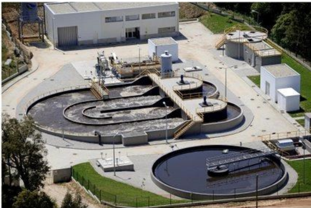
Figura 1: Vista geral da ETAR de Monção
