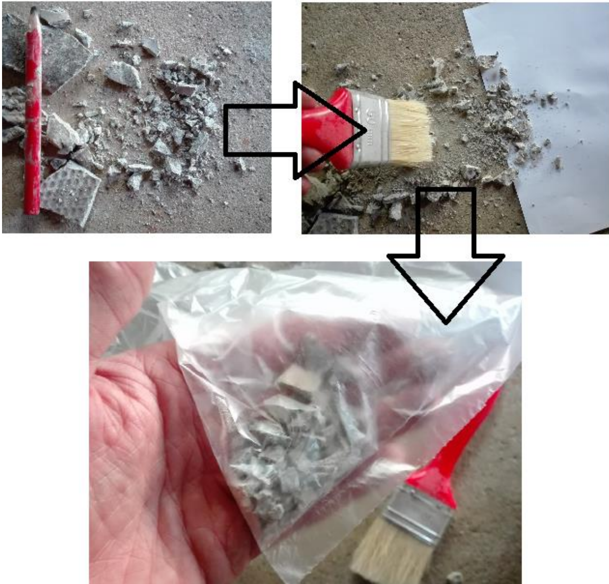
Figura 30 - Imagens da recolha do Amianto.
