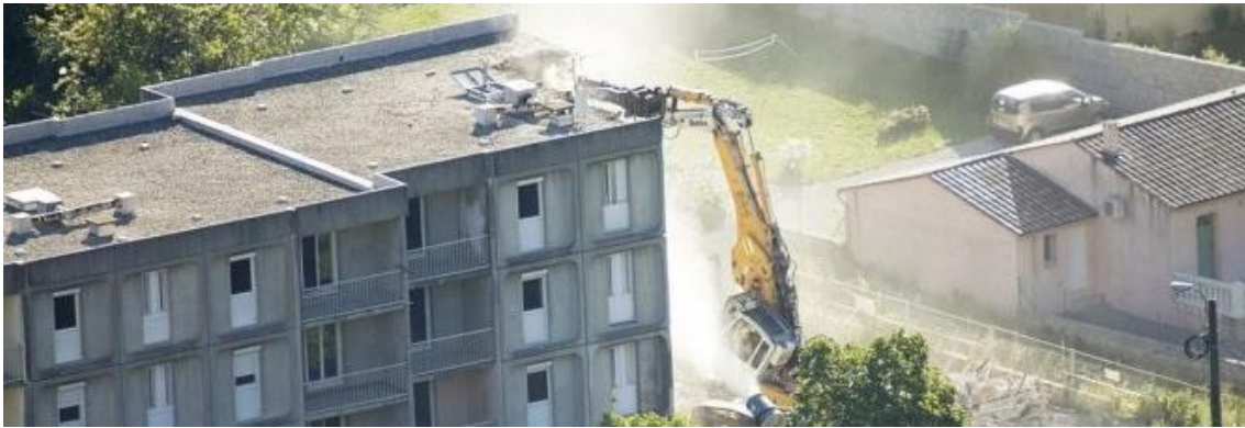
Figura 54 - Aspersores utilizados na demolição de edifícios (Micro Aspersores, 2017).
