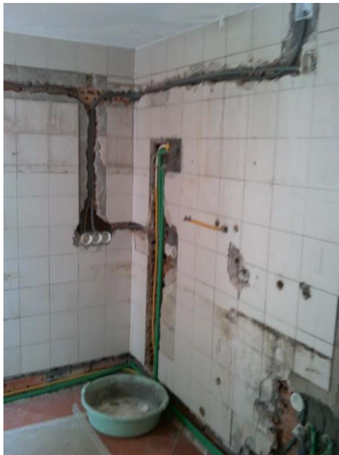
Figura 27 - Abertura de roços das paredes de alvenaria, moradia Afife.
