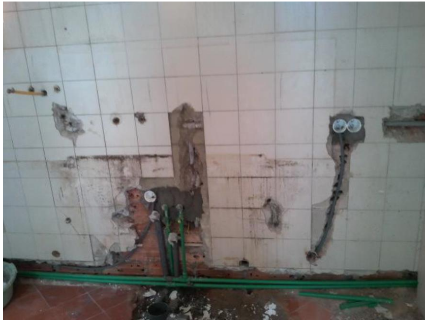
Figura 28 - Abertura de roços da parede de alvenaria e no piso, moradia Afife.
