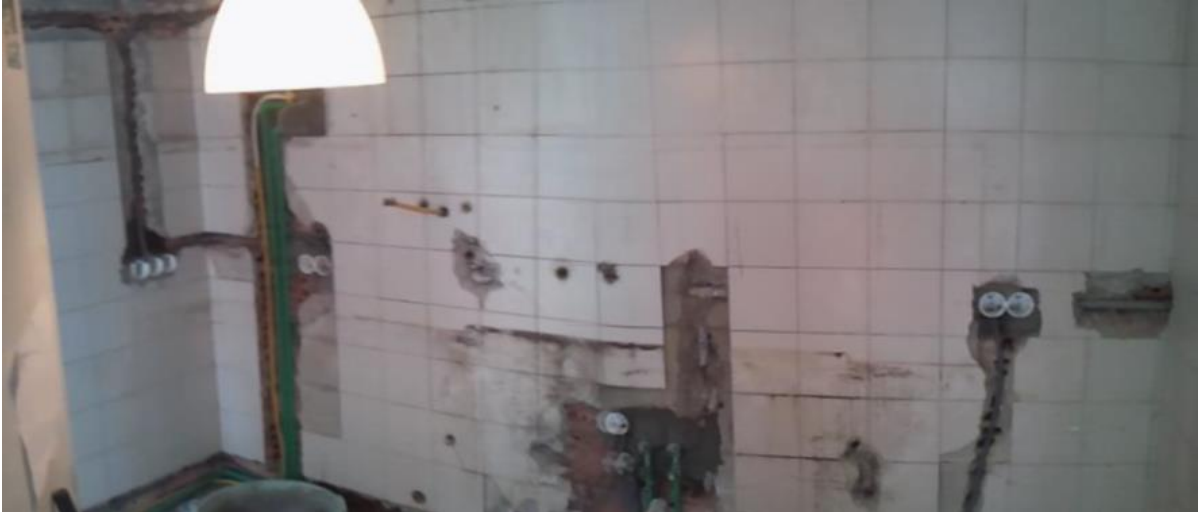
Figura 26 - Remoção do revestimento cerâmico das paredes da moradia, Afife.
