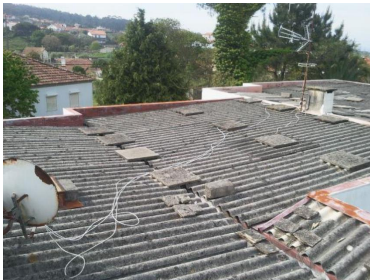
Figura 29 - Cobertura moradia em Placas de Fibrocimento, Afife.
