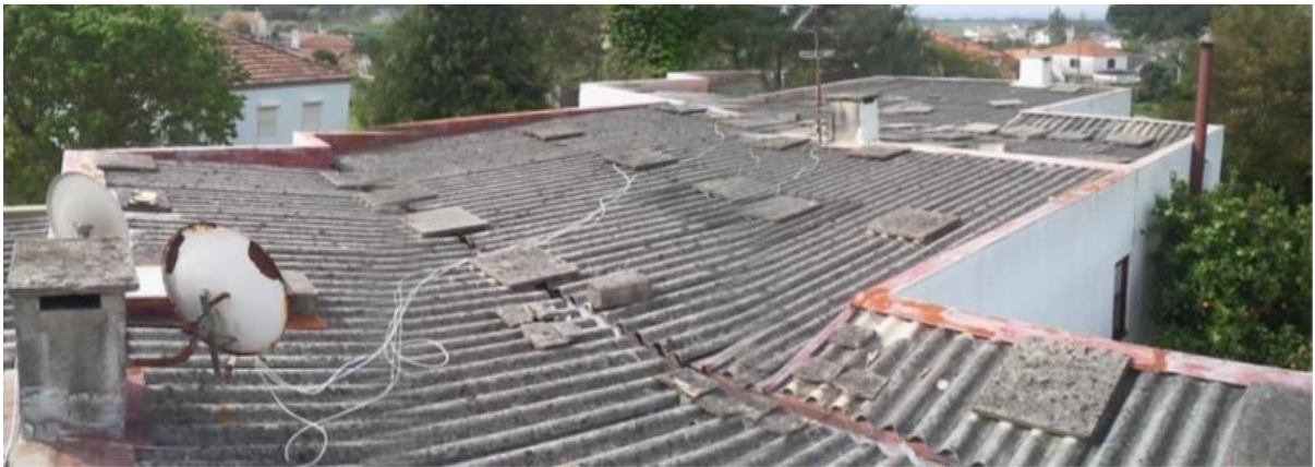
Figura 24 - Cobertura em Placas de Fibrocimento, Afife.
