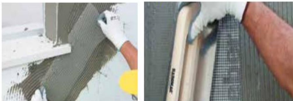
Figura 11 - Aplicação de Reforço nos cantos e Barramento Armado (Weber Saint-Gobain, 2015)
