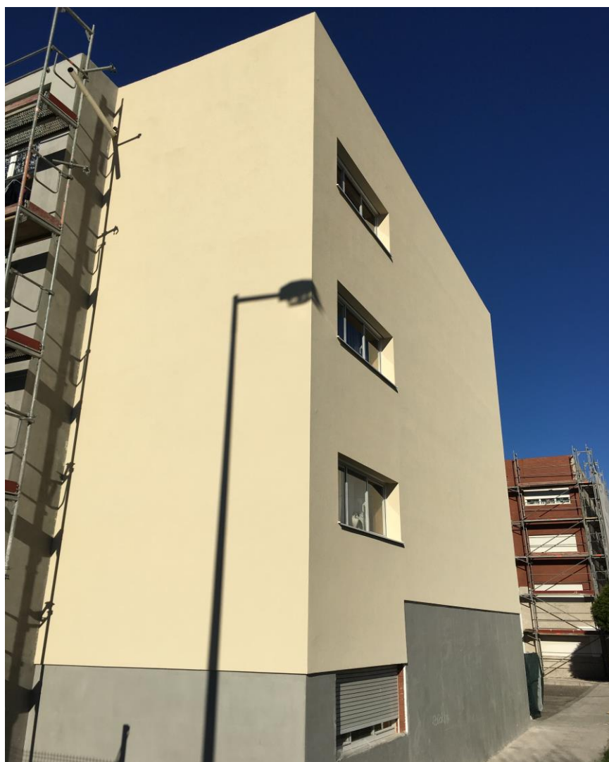
Figura 33 - Solução nº1 concluída
