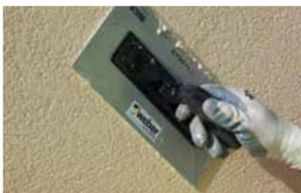
Figura 12 - Aplicação de Revestimento Final (Weber Saint-Gobain, 2015)
