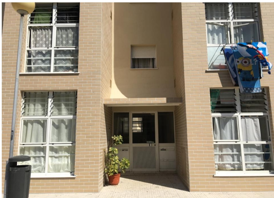
Figura 38 - Cobertura de Entrada de Edifício
