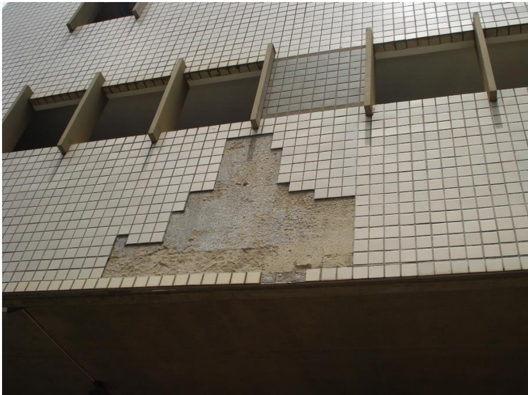
Figura 3 - Destacamento do Revestimento (habitissimo, 2013)
