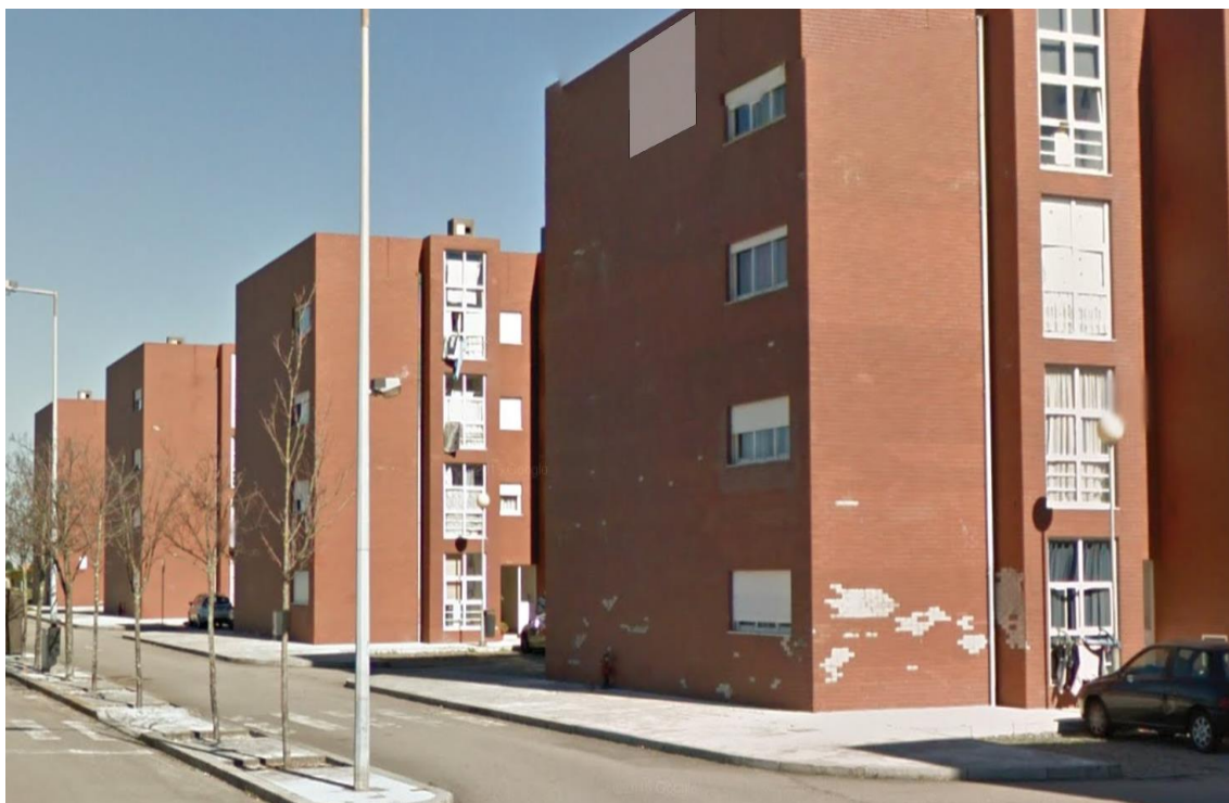
Figura 41 - Antes da Reabilitação
