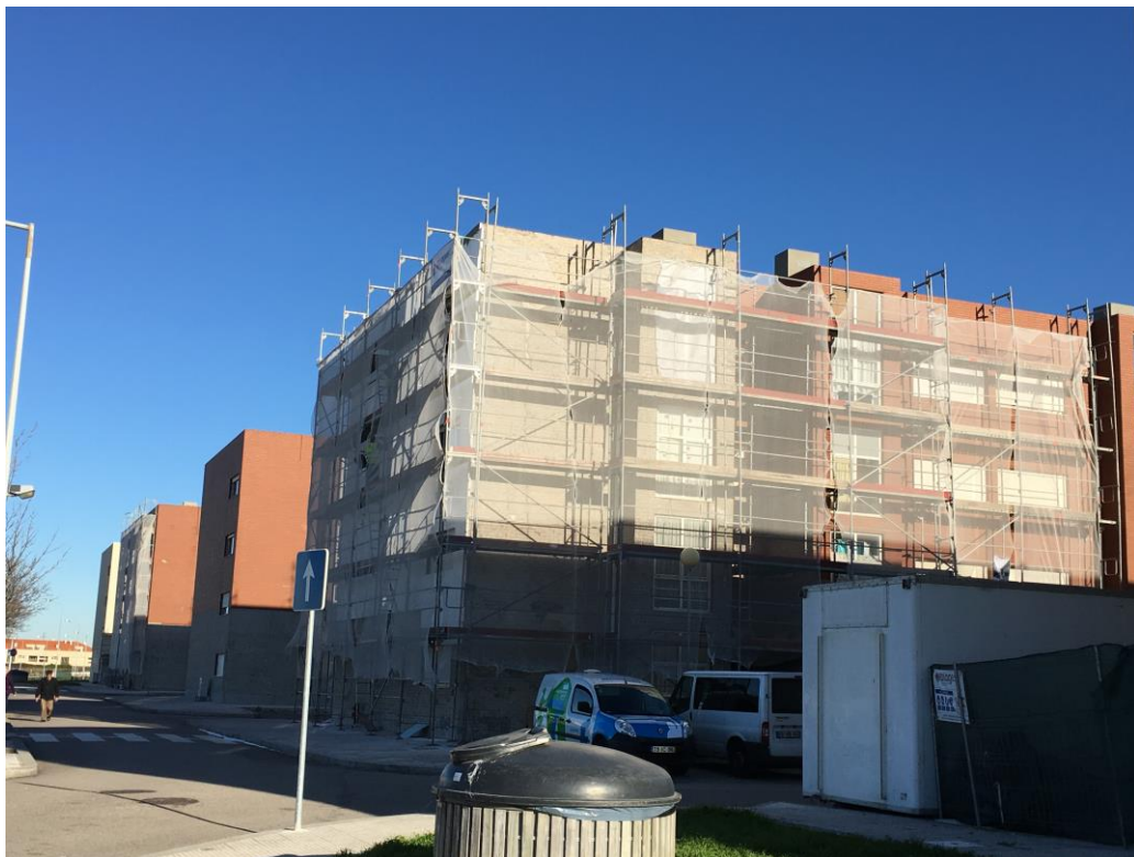
Figura 29 - Picagem do revestimento existente
