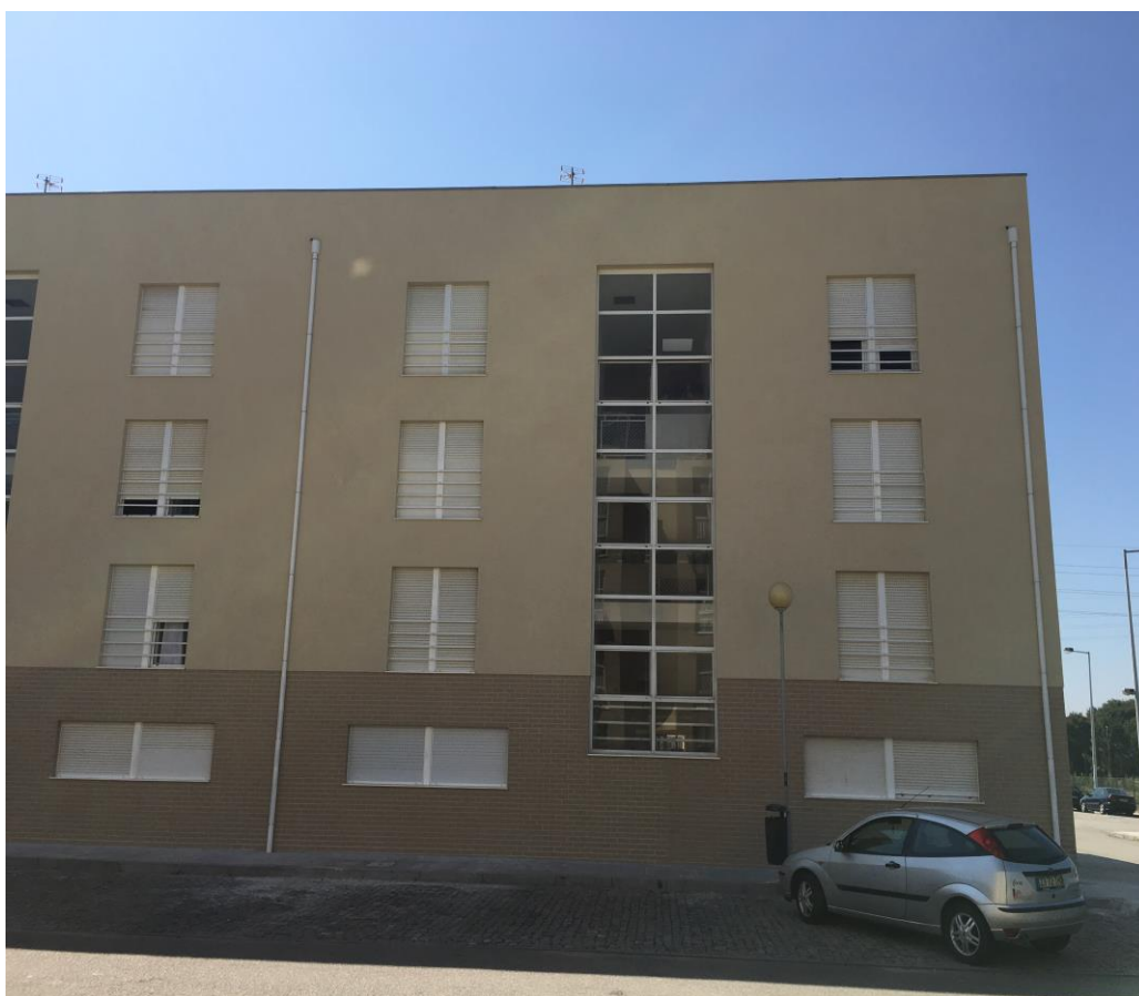
Figura 36 - Solução nº 1 e 2 concluídas
