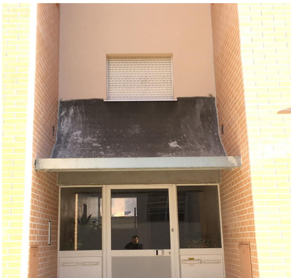
Figura 37 - Impermeabilização da cobertura de entrada
