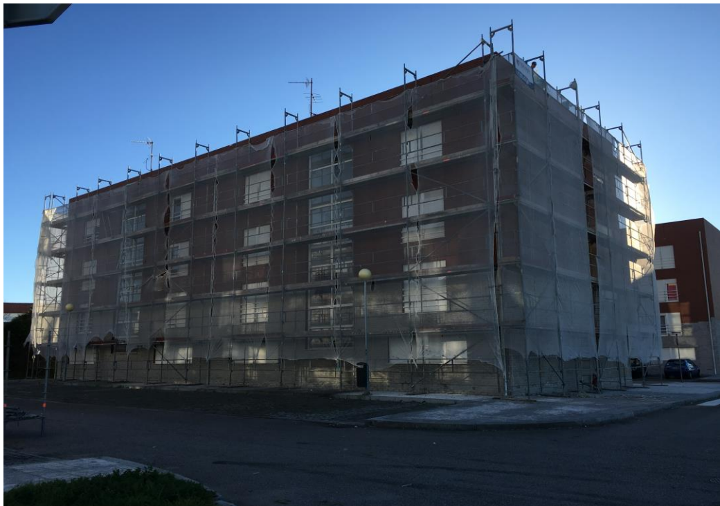
Figura 28 Montagem de Andaime
