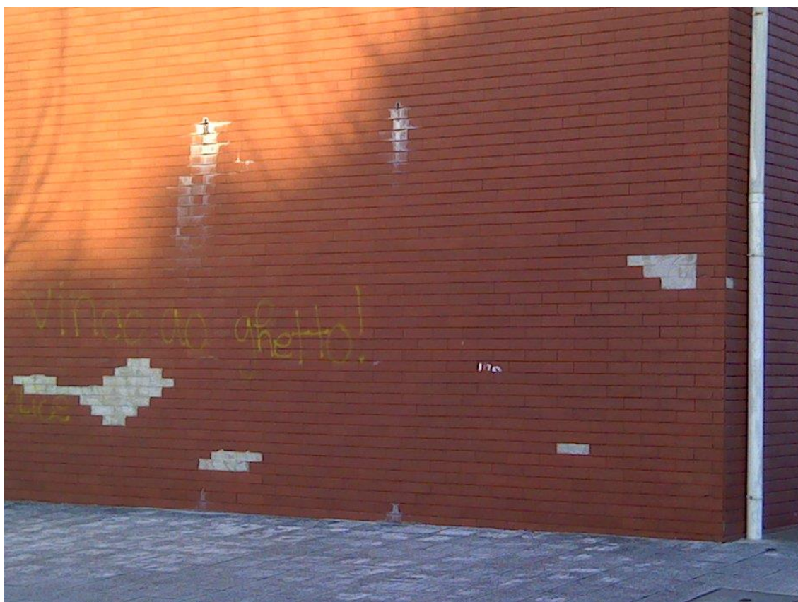
Figura 20 - Escorrimento nos drenos da caixa-de-ar
