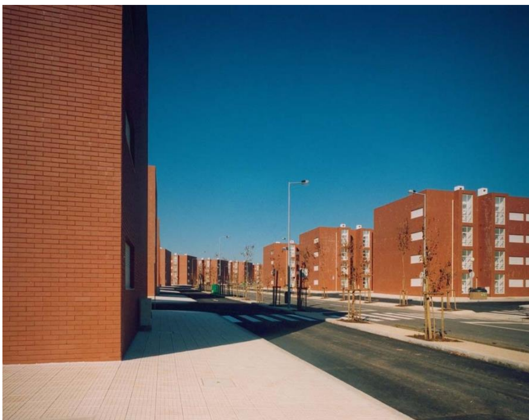
Figura 16 - Conjunto habitacional de Sendim
