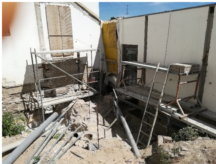
Figura 74 - Abertura de roços (Fonte: Autor)
