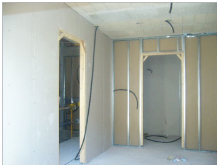
Figura 49 - Paredes interiores em Pladur (Fonte: https://projetos.habitissimo.pt )
