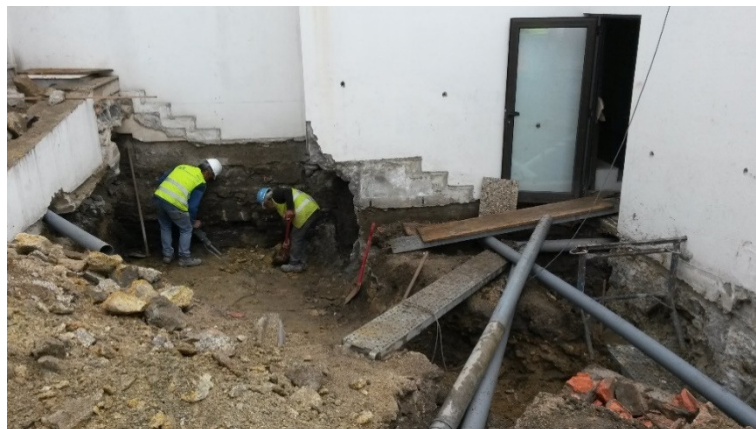
Figura 37 - Escavação poço elevador (Fonte: Autor)
