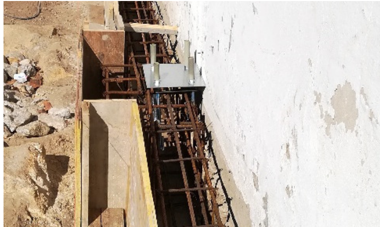
Figura 79 - Chumbadores para os pilares metálicos (Fonte: Autor)
