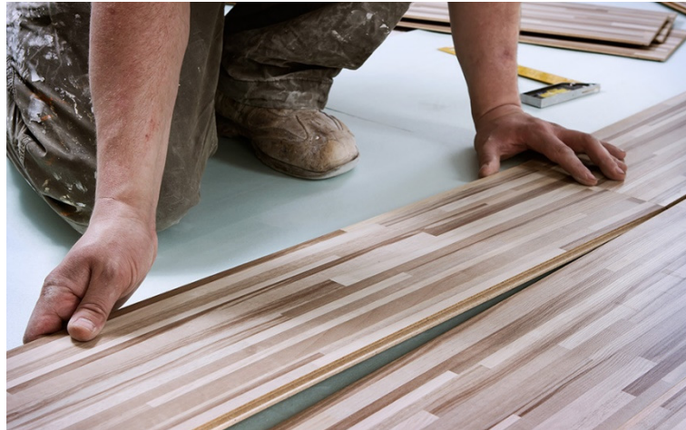
Figura 53 - Execução de Piso Flutuante (Fonte: https://www.obrasemcasa.net )
