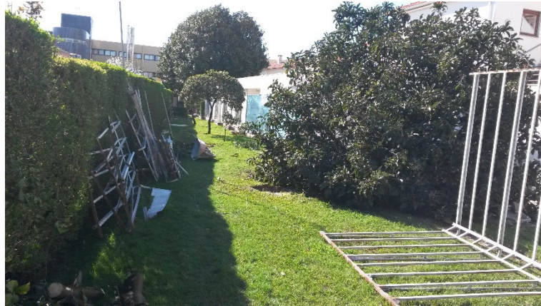
Figura 41 - Limpeza de terreno (Fonte: Autor)
