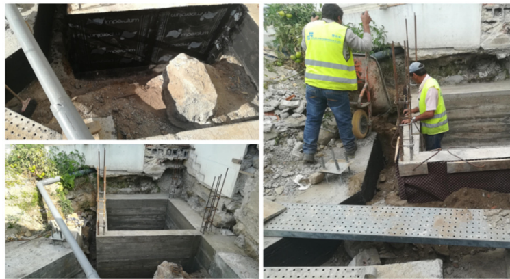
Figura 86 - Figura 84 - Poço do Elevador (Fonte: Autor)
