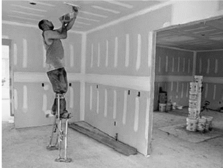
Figura 52 - Revestimento pladur teto (Fonte: https://vintageobras.pt )
