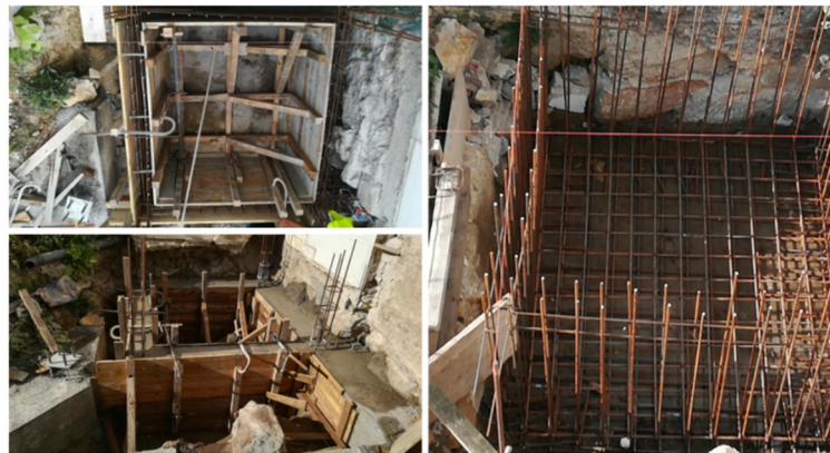
Figura 81 - Armadura, cofragem e betonagem paredes laterais do poço elevador (Fonte: Autor)
