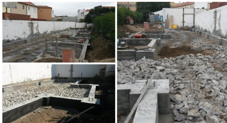
Figura 82 - Execução do piso térreo (Fonte: Autor)
