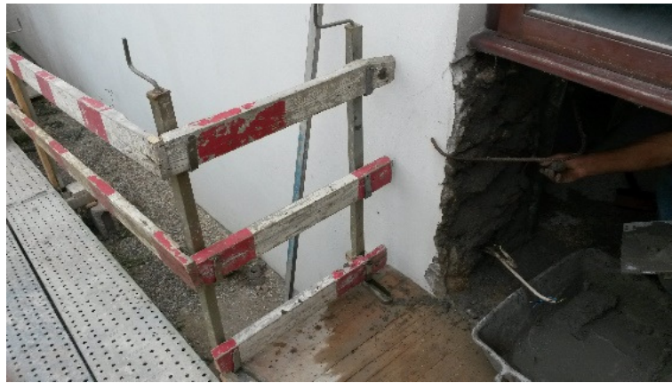
Figura 70 - Construção de uma rampa de acesso (Fonte: Autor)
