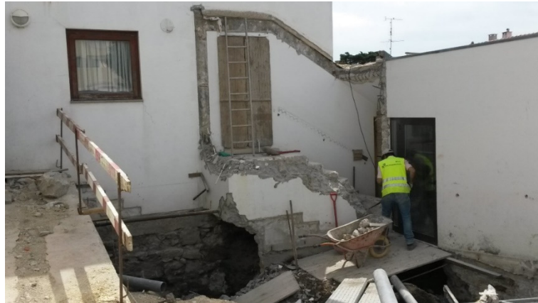
Figura 36 - Demolição da escada existente (Fonte: Autor)
