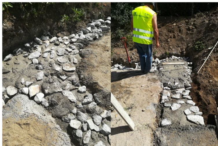
Figura 75 - Execução de betão ciclópico (Fonte: Autor)
