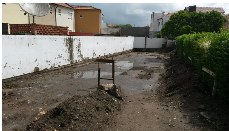
Figura 69 - Balizamento do terreno (Fonte: Autor)
