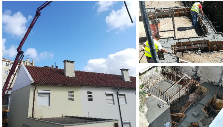
Figura 80 - Autobomba, betonagem vigas, sapatas e poço do elevador e vibração (Fonte: Autor)
