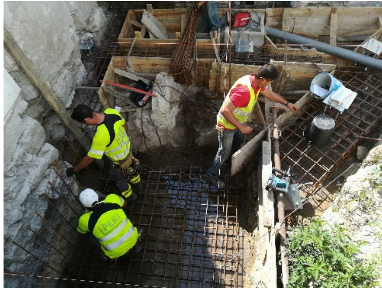
Figura 76 - Armaduras poço elevador (Fonte: Autor)
