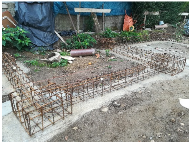
Figura 77 - Armaduras sapatas e vigas de fundação (Fonte: Autor)
