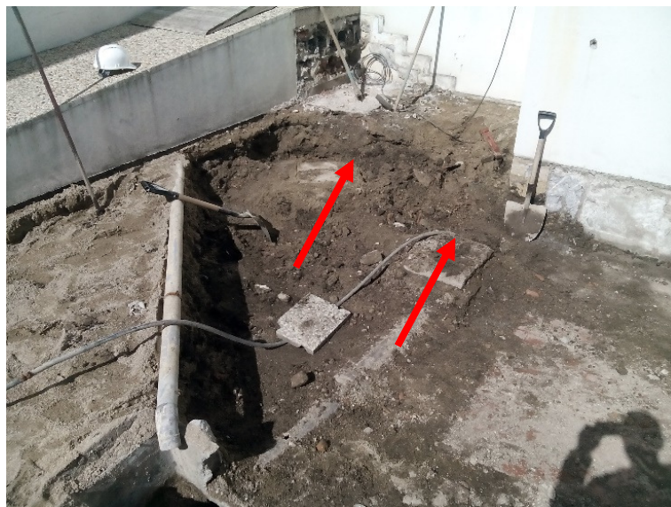
Figura 94 - Caixas de Saneamento existentes
