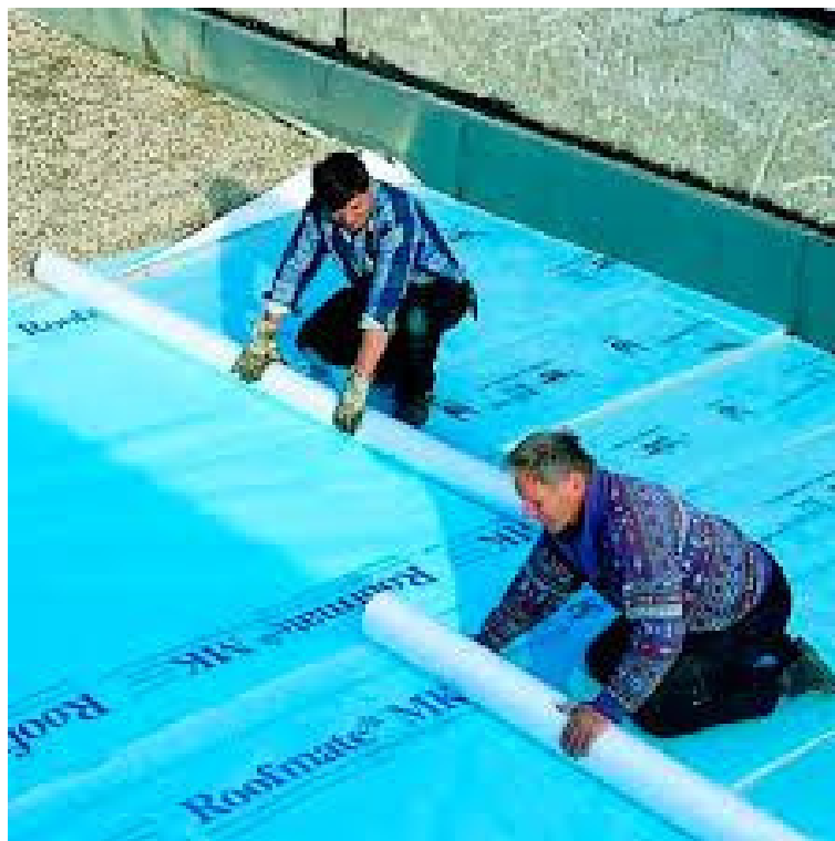
Figura 55 - Isolamentos Coberturas (Fonte: http://www.archiexpo.com )
