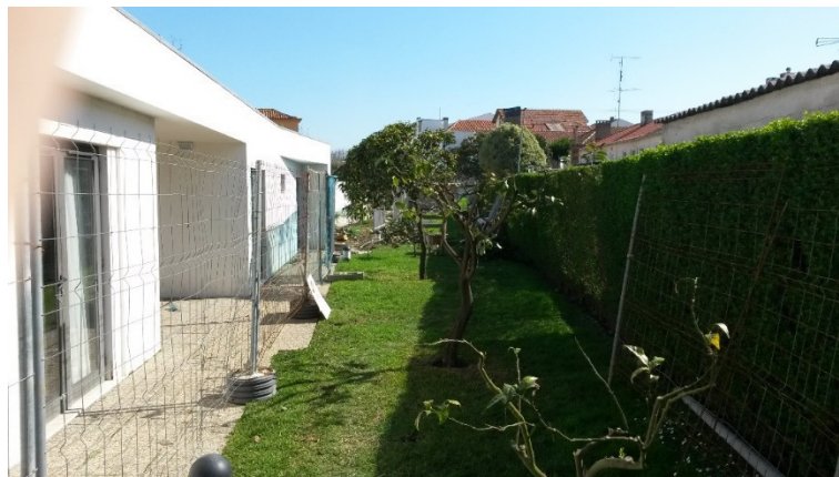
Figura 65 - Montagem do estaleiro (Fonte: Autor)
