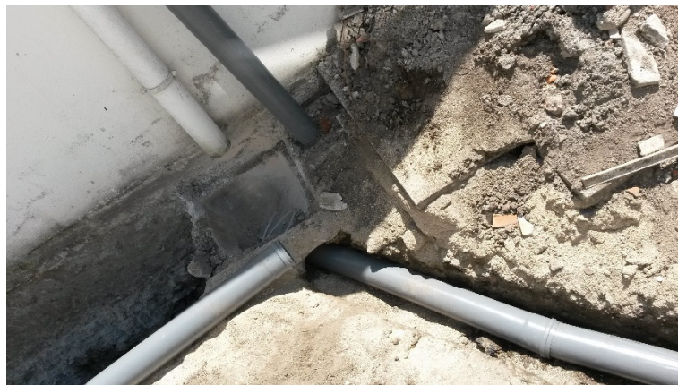
Figura 64 - Execução de drenagem de águas pluviais (Fonte: Autor)
