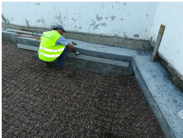
Figura 85 - Execução da betonilha (Fonte: Autor)
