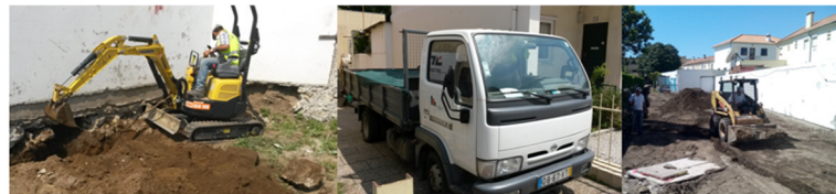
Figura 42 - Movimento de terras (Fonte: Autor)
