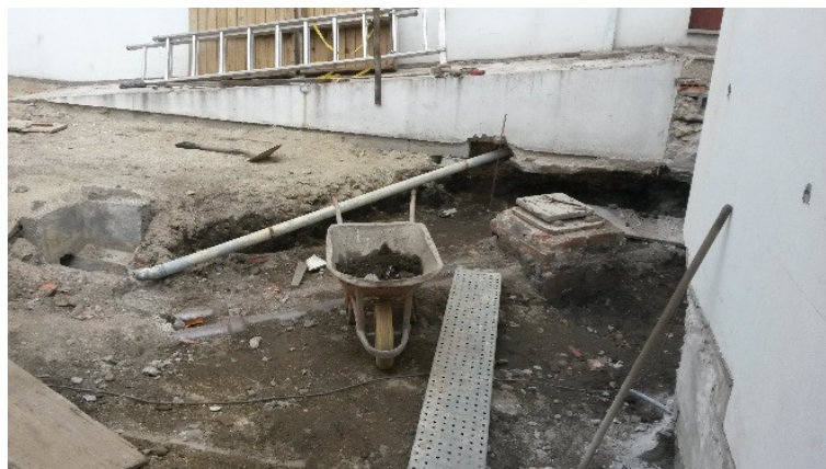
Figura 72 - Desvio das tubagens existentes (Fonte: Autor)
