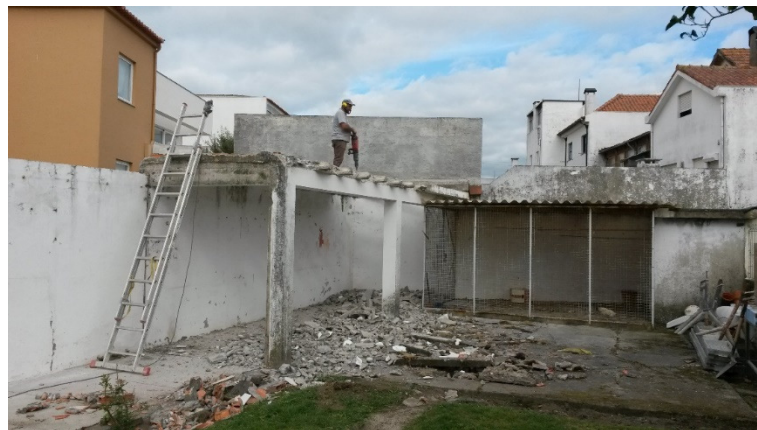
Figura 67 - Demolição da estrutura em betão armado (Fonte: Autor)
