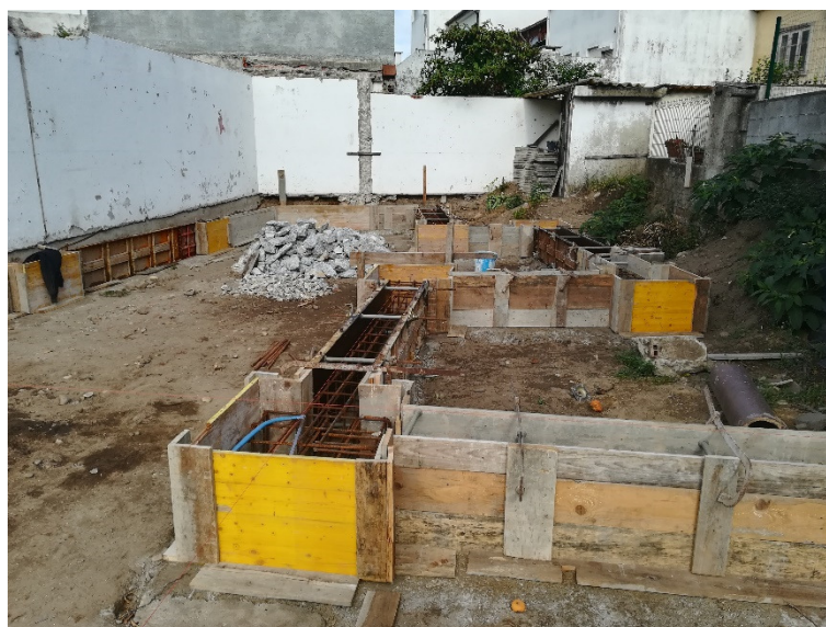
Figura 78 - Cofragens tradicional e racionalizada (Fonte: Autor)
