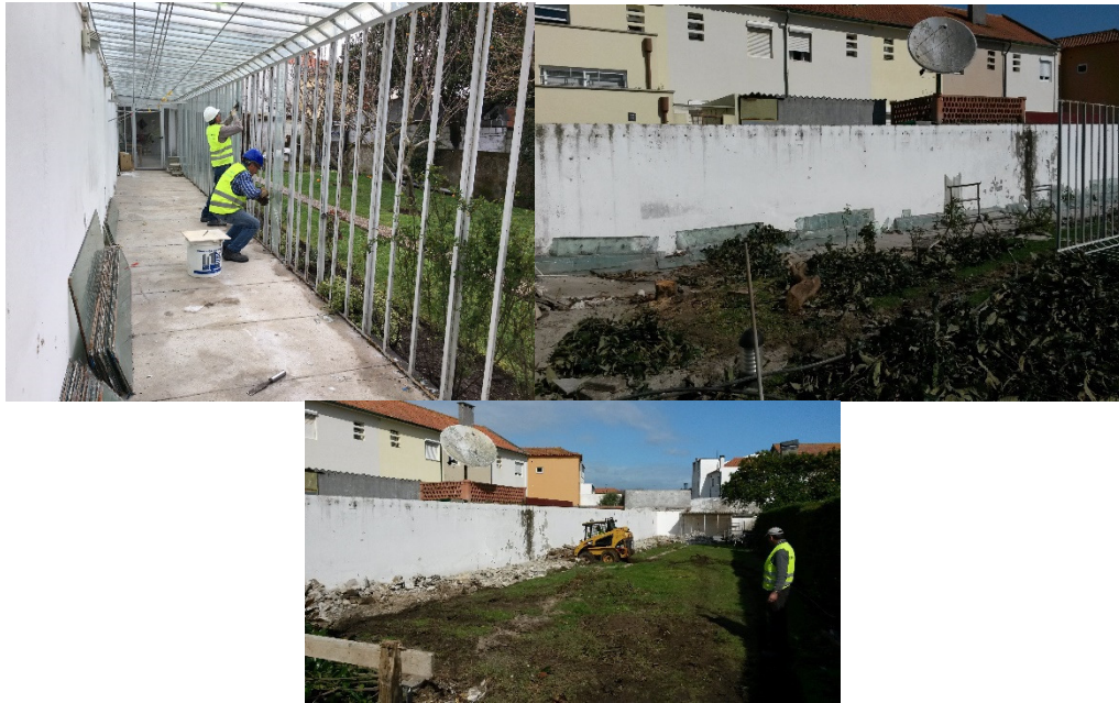
Figura 66 - Desmontagem da estrutura existente, desmatação e limpeza do terreno (Fonte: Autor)
