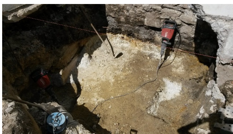
Figura 73 - Escavação poço elevador (Fonte: Autor)
