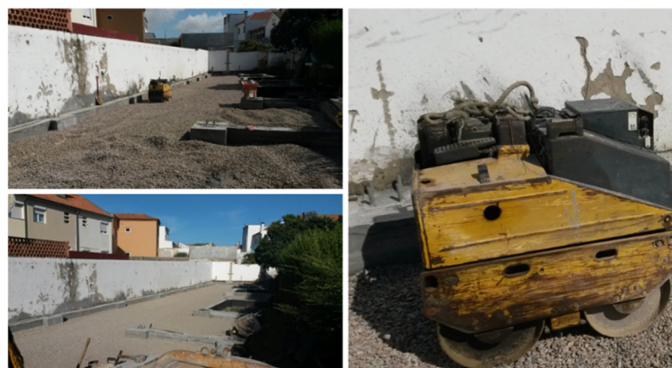
Figura 83 - Execução da camada de brita (Fonte: Autor)
