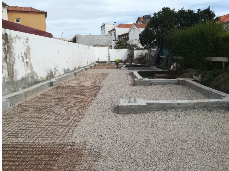
Figura 84 - Execução da malha quadrada (Fonte: Autor)
