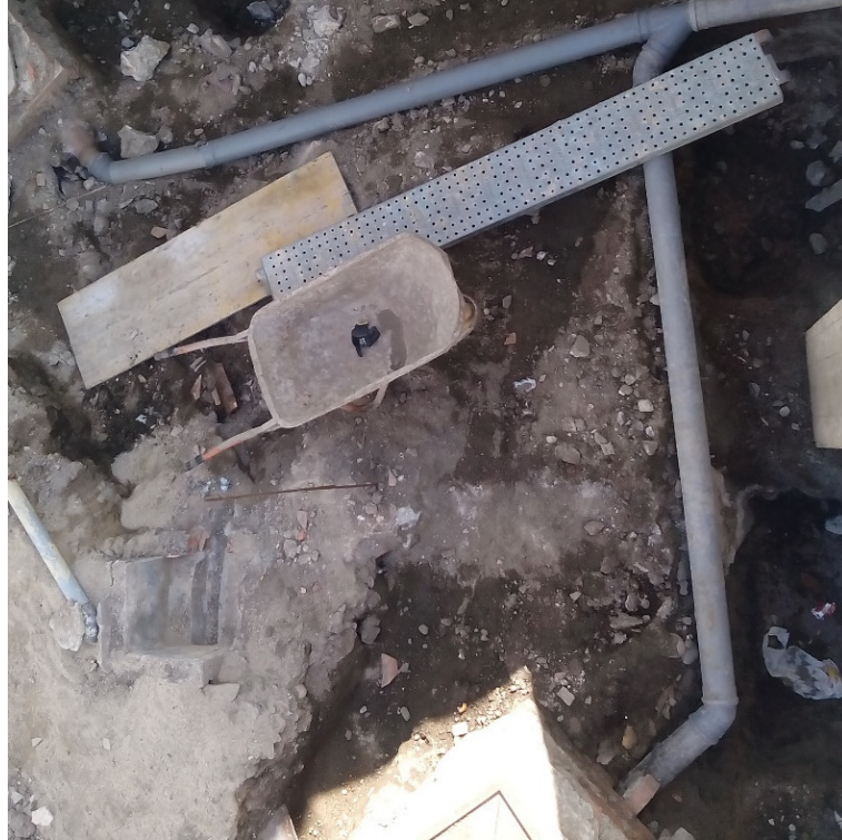
Figura 63 - Execução de rede águas Resíduas (Fonte: Autor)
