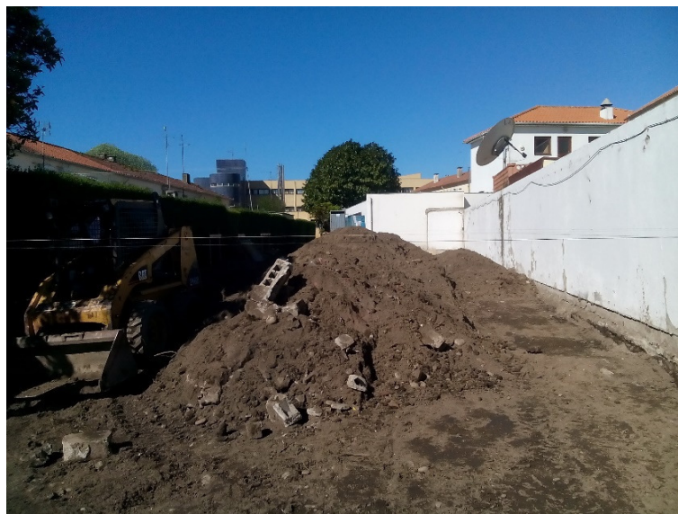
Figura 68 - Escavação do terreno a cota pretendida (Fonte: Autor)
