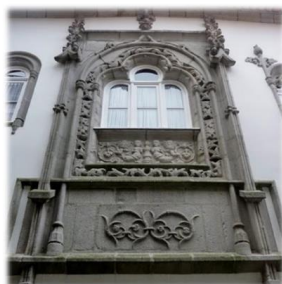
Janela da casa dos Costa Barros – Viana do Castelo.
