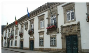
Figura 2. Câmara Municipal de Viana do Castelo (Paço dos Távoras)
