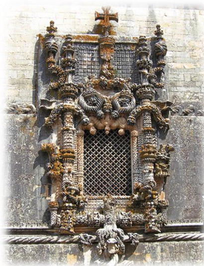
Figura 1. Janela da sala do Capítulo – Convento de Cristo, Tomar
