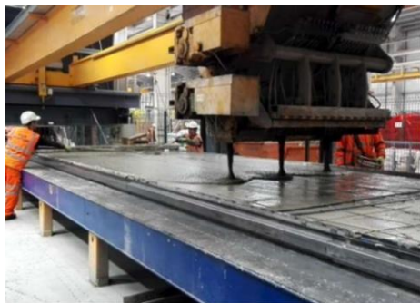
Figura 30 – Exemplo de betonagem
