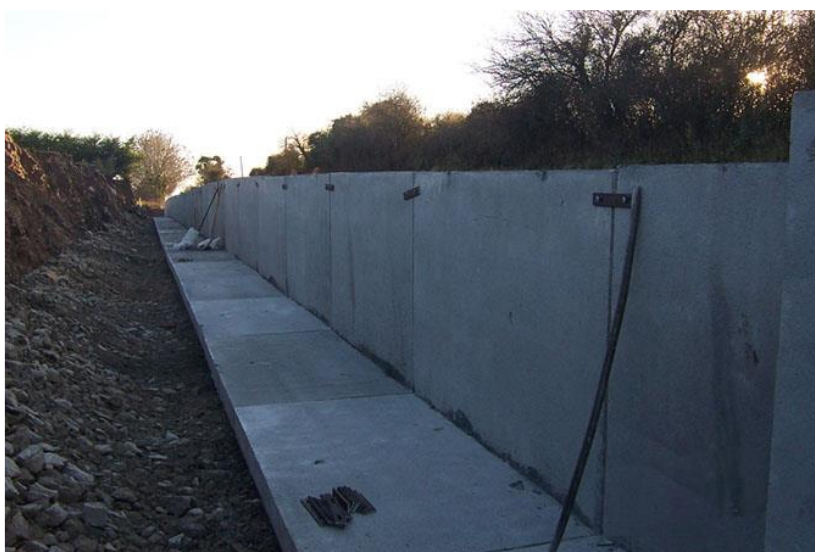
Figura 11 – Parede de retenção em L
