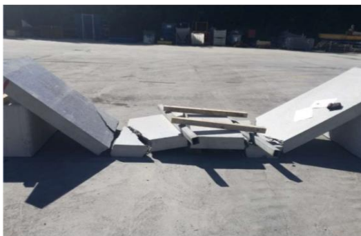
Figura 35 – Foto global do painel 1 depois do colapso
