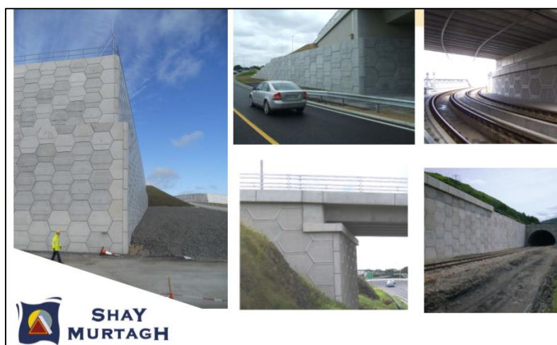
Figura 8 – Pilares da ponte reforçada A1
