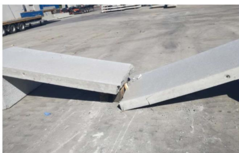
Figura 37 – Foto global do painel 2 depois do colapso
