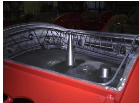
Figura 29 – Armadura colocada
