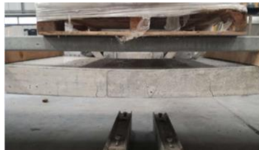
Figura 40 – Foto com pormenor do painel 4 depois de fissurar
