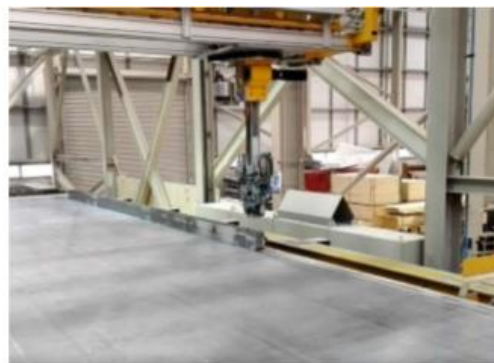
Figura 27 – Robô a instalar a cofragem
