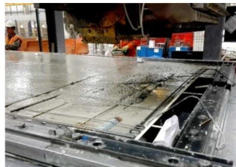
Figura 31 – Exemplo de betonagem
