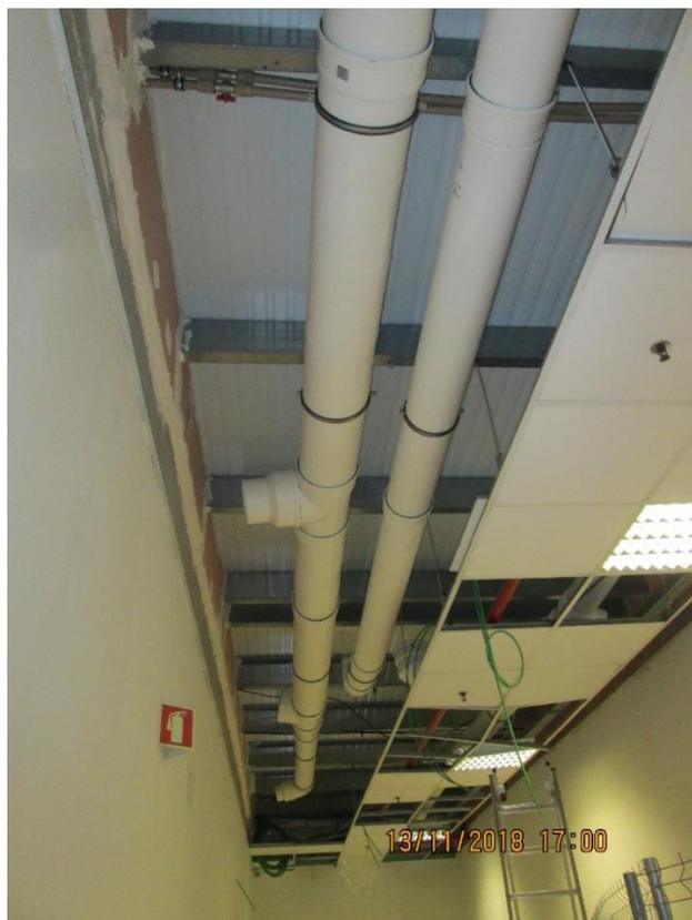
Figura 24 - Instalação AVAC em tubagem PVC
