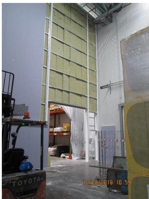
Figura 17 - Montagem parede divisória Injeção N3/Armazém
