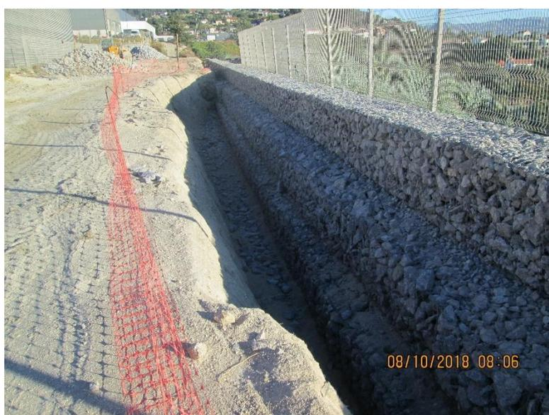
Figura 21 - Contenção de terras em muro de gabiões
