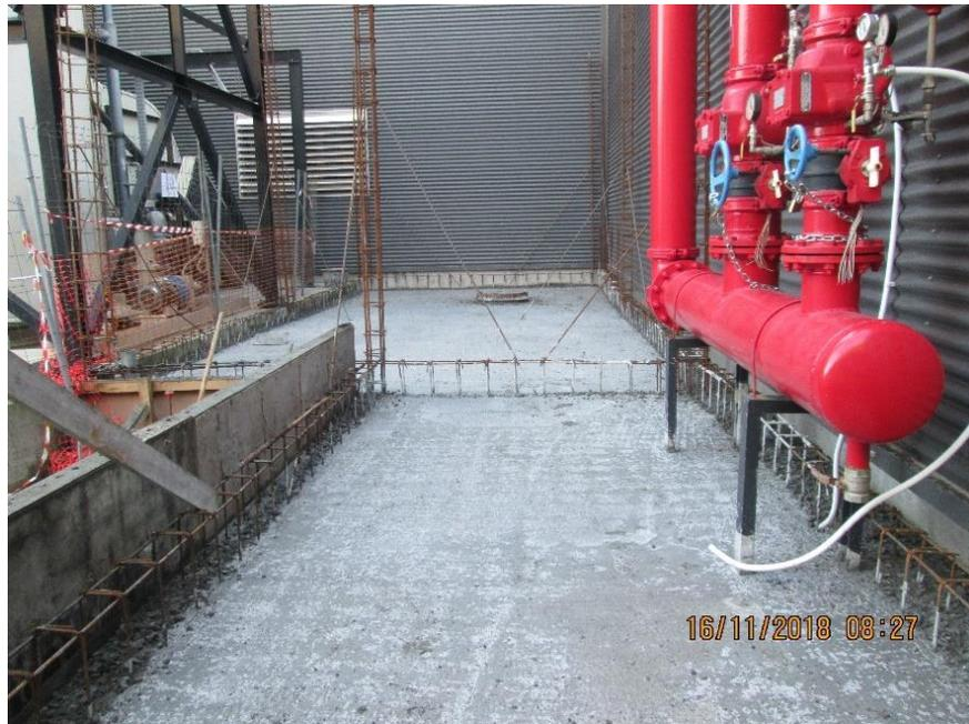
*Figura 31 - Ensoleiramento zona de carregamento de baterias dos empilhadores e comandos do grupo de sprincklagem*
