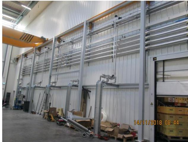
*Figura 19 - Estrutura apoio parede divisória*
