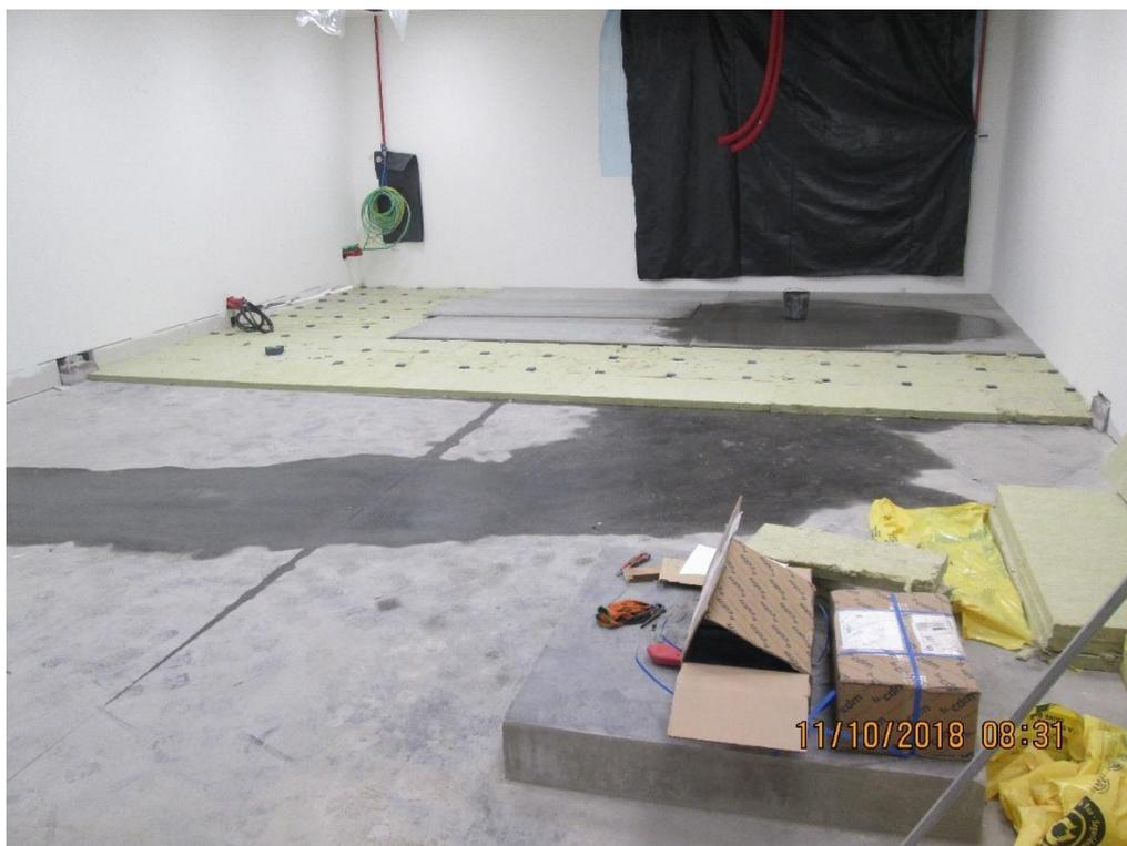
*Figura 14 - Pormenor construtivo laje antivibrática*
