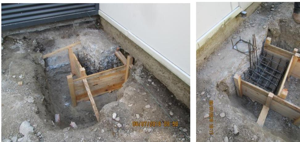
Figura 13 - Incorporação de sapatas novas com sapatas existentes
