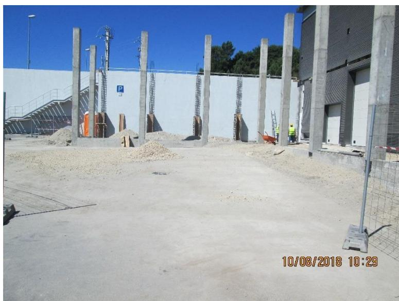
*Figura 11 - Estrutura betão armado Oficina de Moldes*
