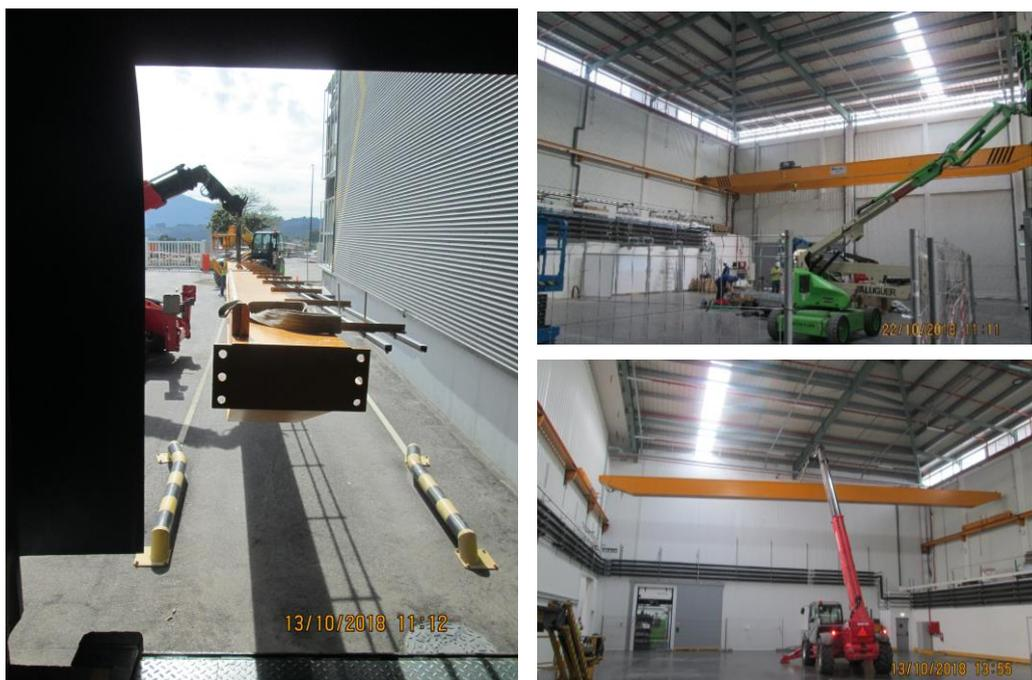
*Figura 18 - Instalação de ponte rolante*
