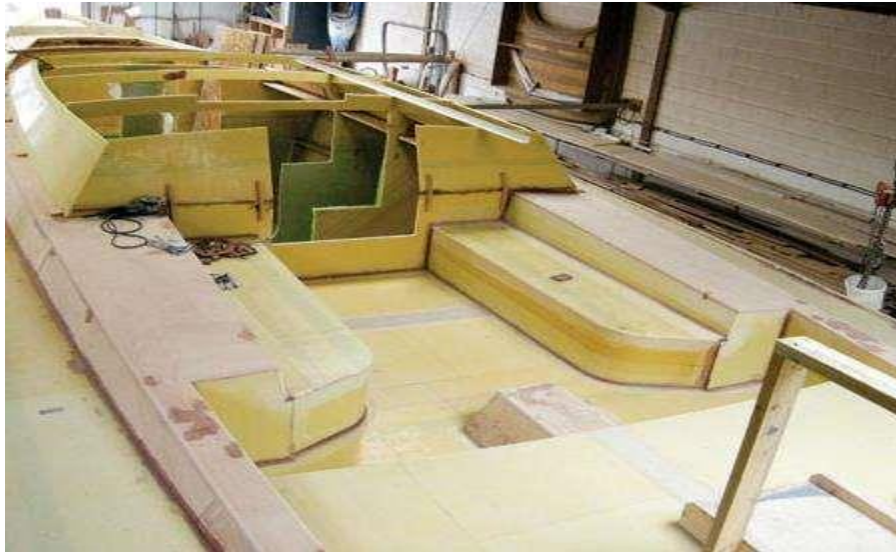
Figura 12 - Processo montagem madeiras
