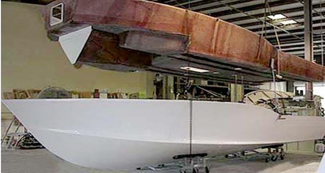
Figura 13 - Processo união Casco/Coberta
