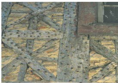
Figura 6. Estrutura de parede com taipa de rodízio (edifício no centro histórico)
