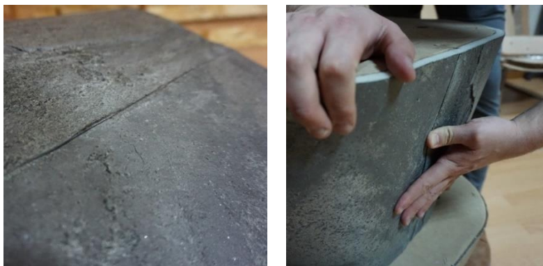
Figura 77 - Emenda da folha de pedra no casco (à esquerda), pressão sobre a emenda do revestimento (à direita). Fonte 118
