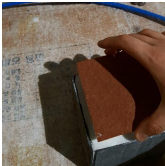
Figura 188 - Colagem da espuma no casco em forma de cubo (à esquerda) Colagem da folha de pedra sobre a espuma que reveste o casco (à direita). (Cubo com dimensões de 200mmX200mmX200mm)
