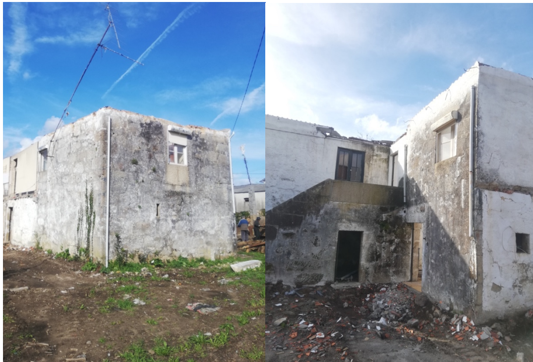
Figura 4- Visita a obra
