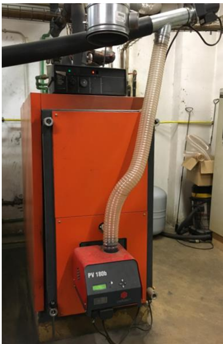
Figura 14 - Caldeira a Pellets
