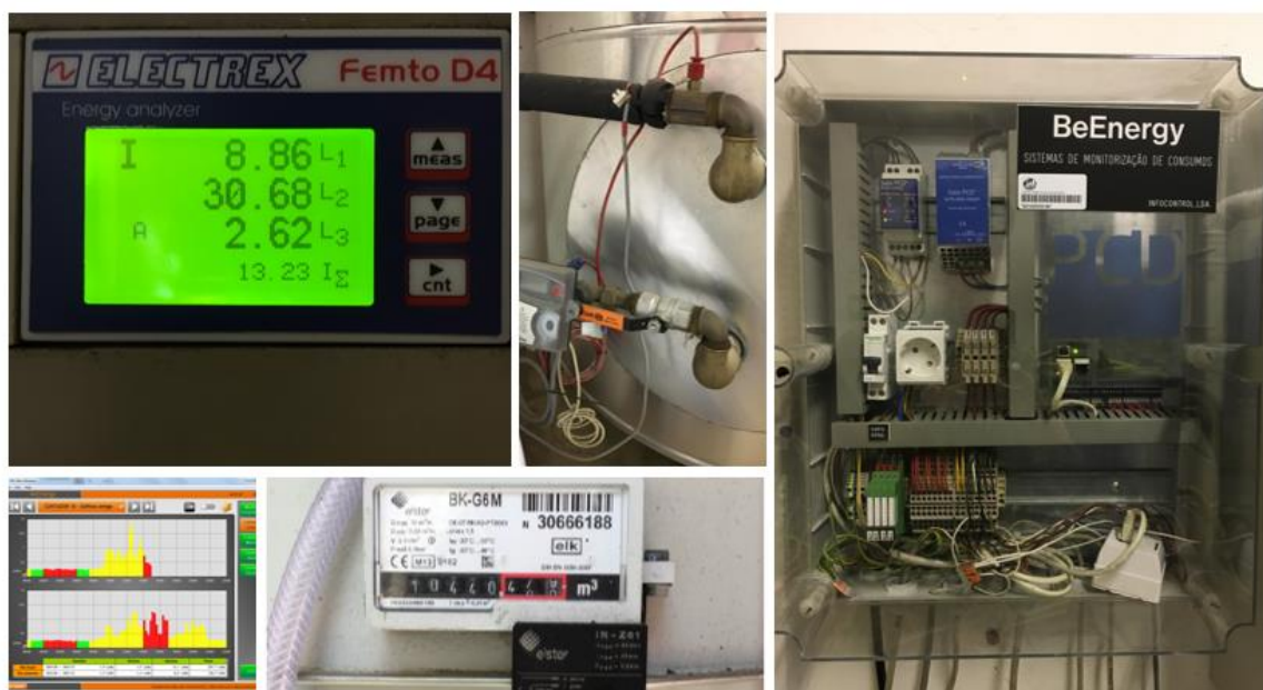
Figura 17 - Sistema de monitorização
