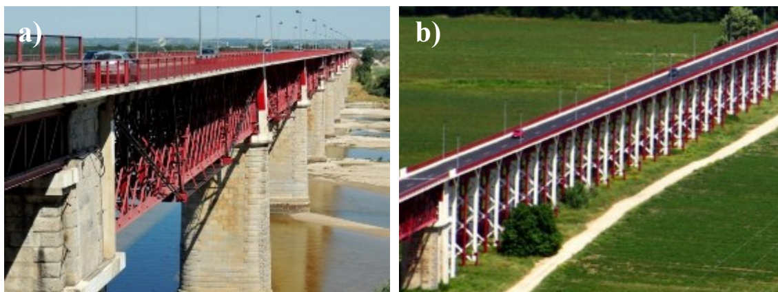
Figura 5.3 - Ponte D. Luís na atualidade, a) parte sobre o leito do rio Tejo (Torres, 2013), b) parte sobre a margem esquerda (Garcia, 2012).
