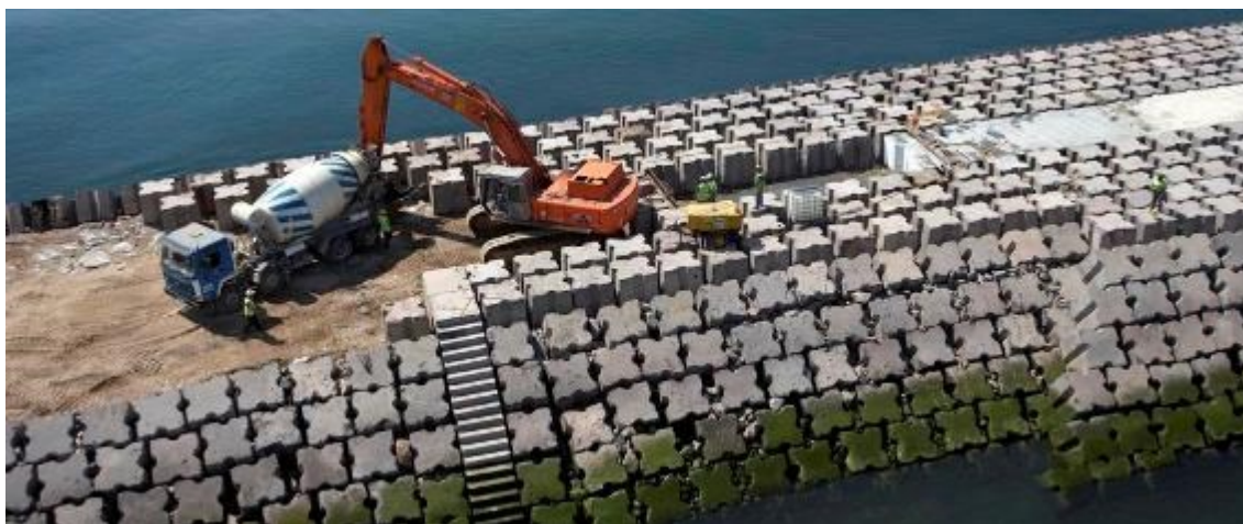
Figura 4.4 - Colocação do manto resistente no quebra-mar destacado. Fonte: (IRMÃOS CAVACO, n.d.)
