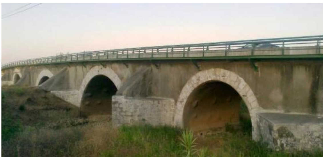
Figura 5.5 - Ponte da Asseca na atualidade - lado montante (Cardoso, 2012)
