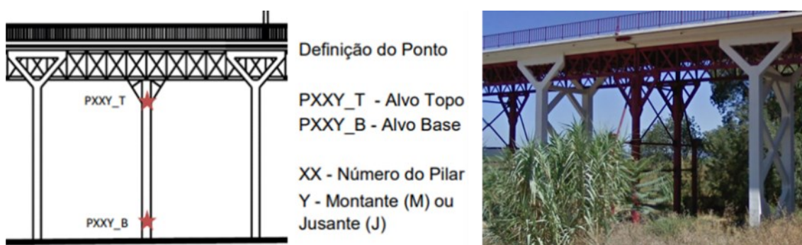
Figura 5.23 - Posição vertical dos sensores nos pilares da ponte D. Luís. Esquema: (Infraestruturas de Portugal, n.d.), Fotografia: Google Street Maps
