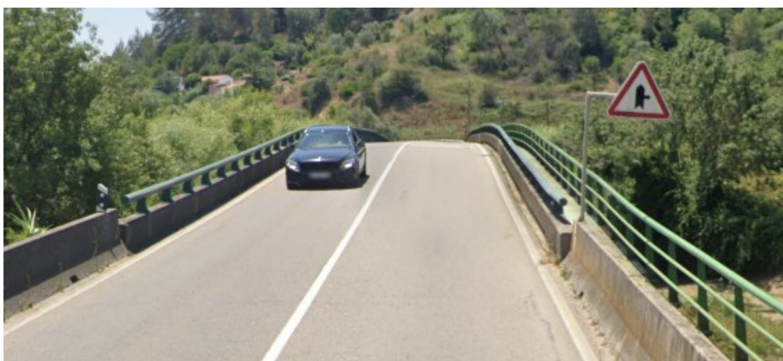
Figura 5.6 - Ponte da Asseca – vista de Santarém para o Cartaxo (Google Street View).
