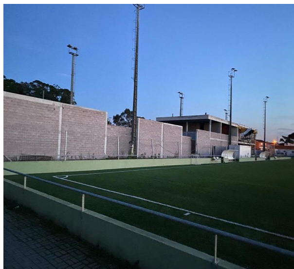
Figura 6. Construção das novas instalações da academia.
