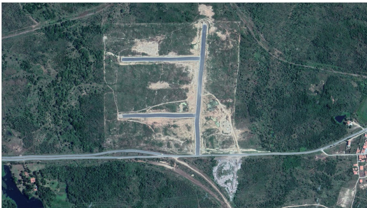
Figura 5: Primeira fase de implantação do Guaiuba Chemical Park em 26/06/2018. Google Earth.
