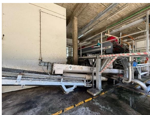
Figura 2.11. Desidratação mecânica das lamas (centrífuga).
