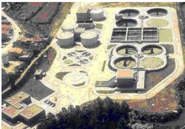
Figura 2.1. Vista aérea da ETAR. (Autor, 2024).
