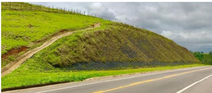
Figura 16: Exemplo de talude, Yanagira (2021, p. 83).
