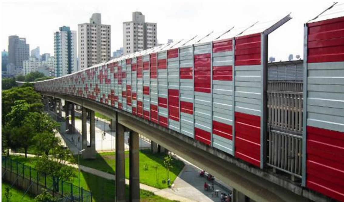
Figura 21: Barreira acústica em viaduto, (ISOLTOP, 2020).
