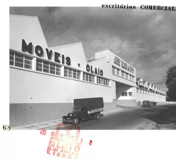
Figura 22- Edifício Olaio Fonte: Olaio
