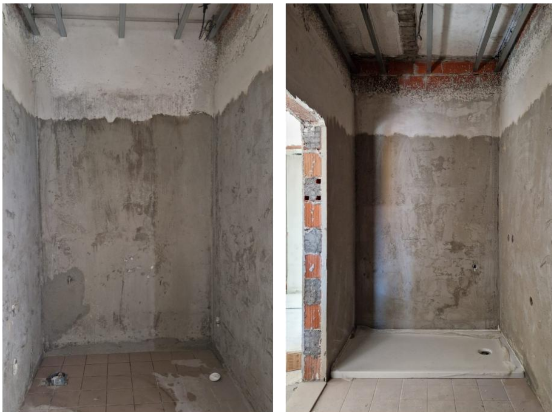
Figura 13 - Imagem da instalação sanitária privativa, em fase de obra, destinada ao quarto acessível;
