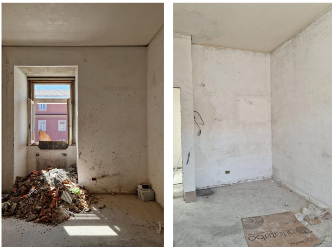
Figura 14 - Vista geral do quarto adaptado em fase de construção, onde se observam as janelas amplas e a entrada de luz natural; Fonte – Daniel Silva
