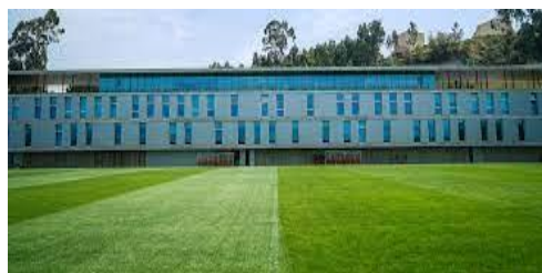
Figura 2 - Edifício Cidade Desportiva
