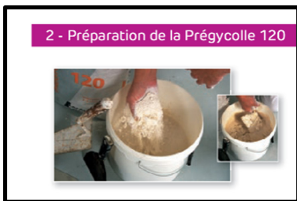
Figura 23- Preparação da cola Pregycolle
