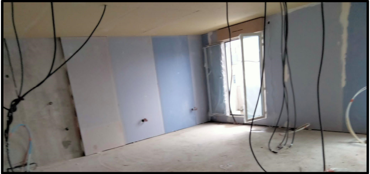
Figura 33 - Aplicação das placas Pregymax em obra
