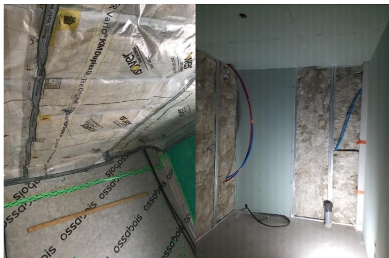
Figura 43 - Aplicação de acabamento em gesso cartonado em parede
