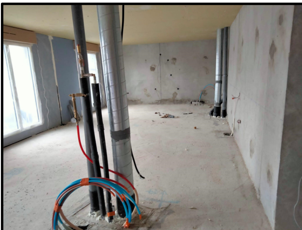
Figura 32 – Paredes preparada para receber placas Pregymax
