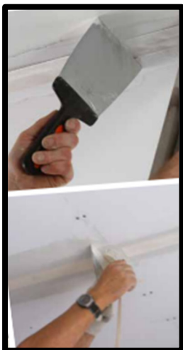
Figura 28- Finalização de juntas
