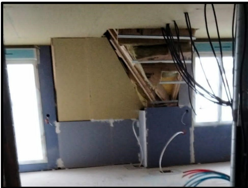
Figura 30 - Aplicação de Isolamento em muros inclinados
