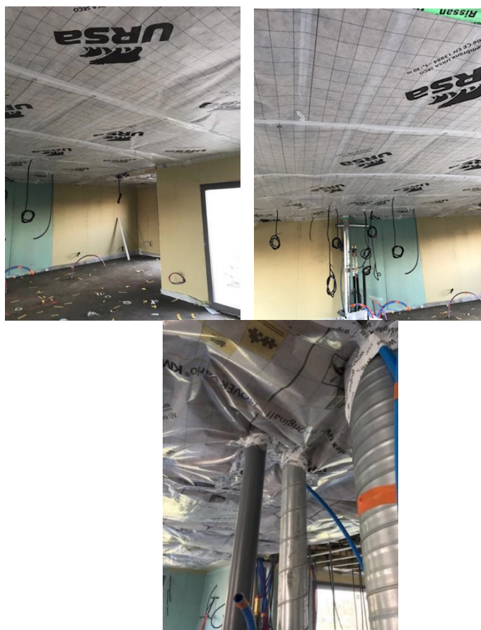
Figura 44 - teto falso pronto a receber acabamento de gesso cartonado
