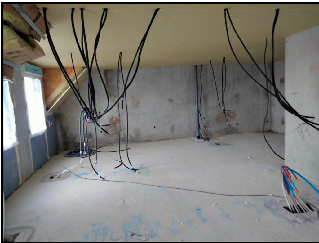
Figura 31- Teto finalizado pronto a receber acabamento
