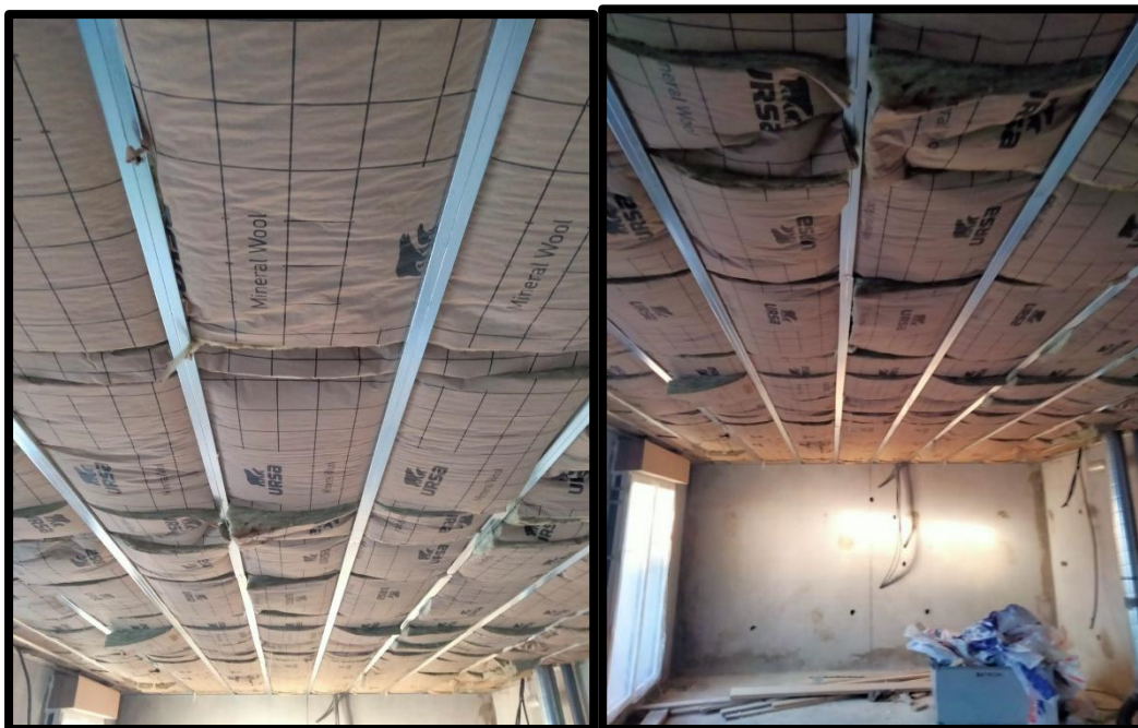
Figura 29- Teto após aplicação de isolamento pronto a receber acabamento
