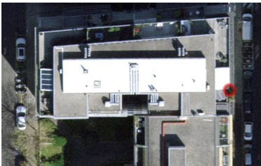
Figura 16 - Fotografia aerea, coberturas planas (Inpto Engineering)
