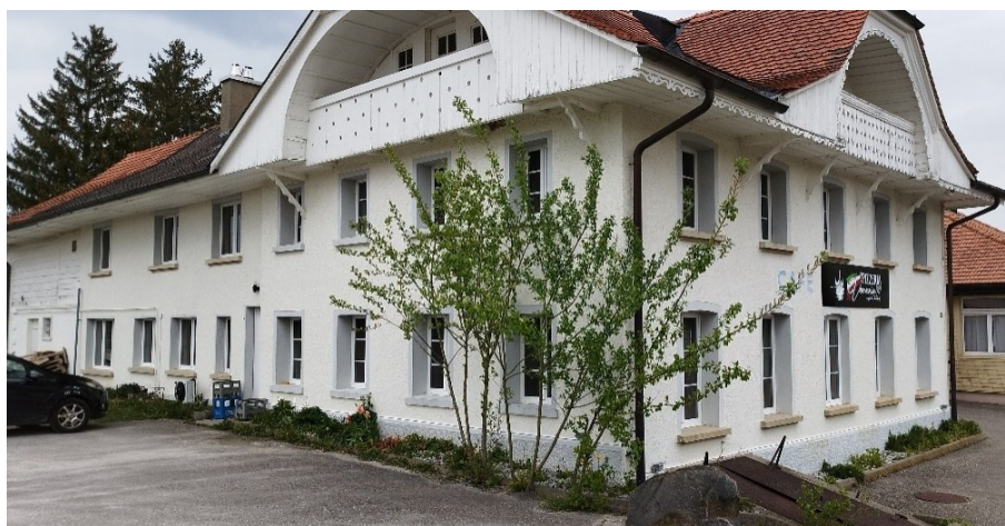
Figura 18 - Complexo de 4 edifícios antes da desconstrução parcial (Inpto Engineering)
