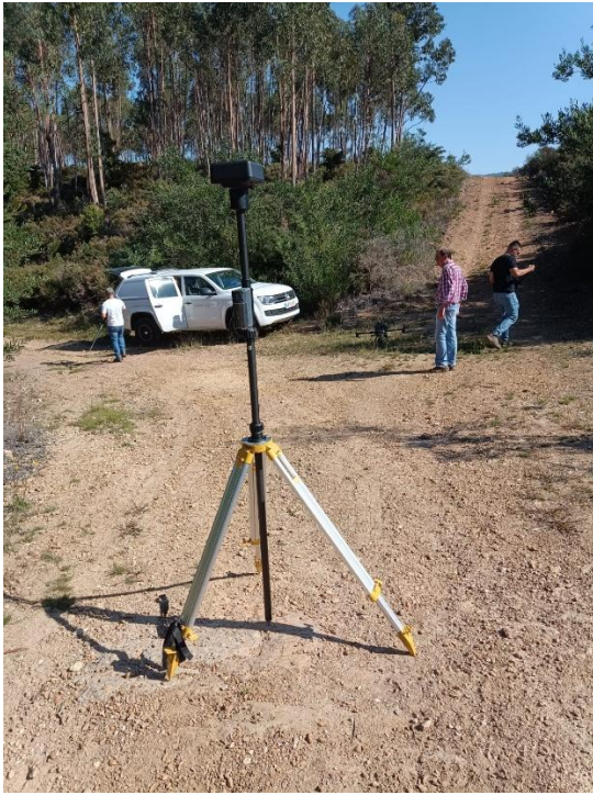
Figura 3.6. Instalação do sistema RTK.
