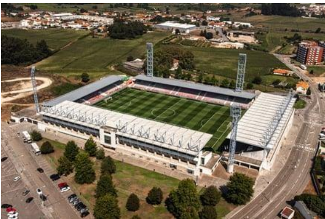
FIGURA 3 - ESTÁDIO MUNICIPAL CIDADE BARCELOS
