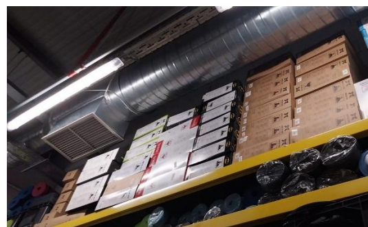
Figura 36 – Armazenagem de Equipamentos nos topos dos Racks.
