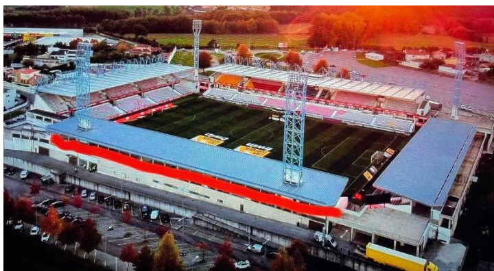
Figura 1 - Estádio Cidade de Barcelos
